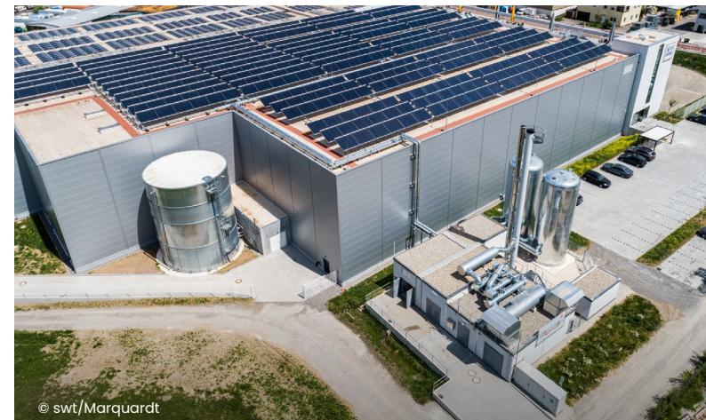
Damit können insgesamt zusätzliche 175 kW thermische Leistung mittels Wärmepumpe auf ein höheres Temperaturniveau angehoben und ebenfalls nutzbar gemacht werden. Ergänzt wird das System durch einen 3.000-kW-Spitzenlastkessel und zwei große Wärmespeicher.
